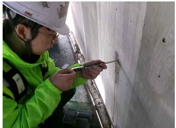
탄산화깊이 측정 현황
